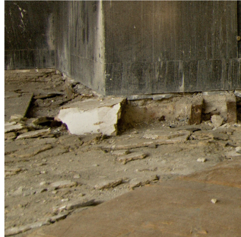
DET. 5 styk nerezového tělesa fontány s novou podlahou
